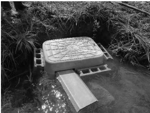
川岸に設置している様子
