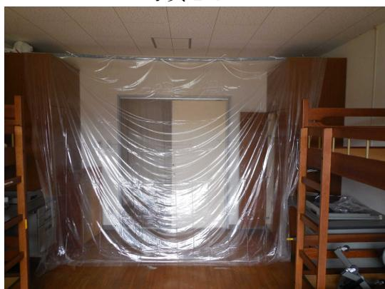
写真9 : 男子寮南寮1階廊下遮断シート設置状況
